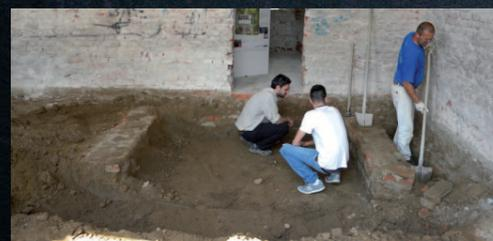
scavo interno e formazione di vespaio per isolamento contro terra
