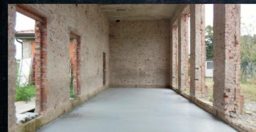
realizzazione della soletta in cemento armato
