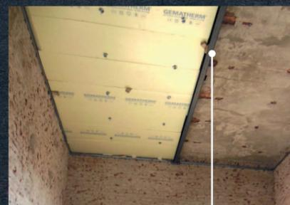
consolidamento del solaio di copertura posa della trave longitudinale
